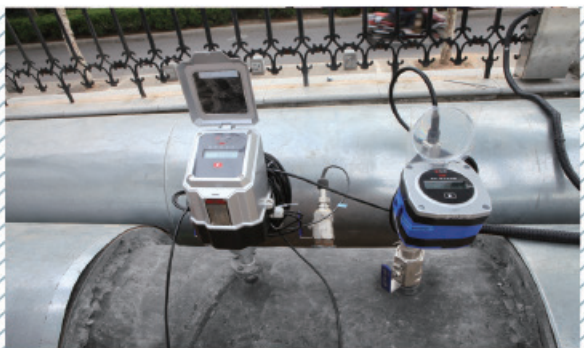
郑州一次主管网检测项目
